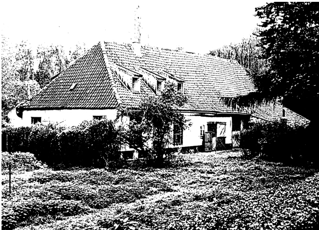
Oude hoeve bij kasteel Stapelen aan zijde ingang Prins Hendrikstraat. Ook bekend onder de naam Het Snoekenhuis. Gesloopt in 1985.
