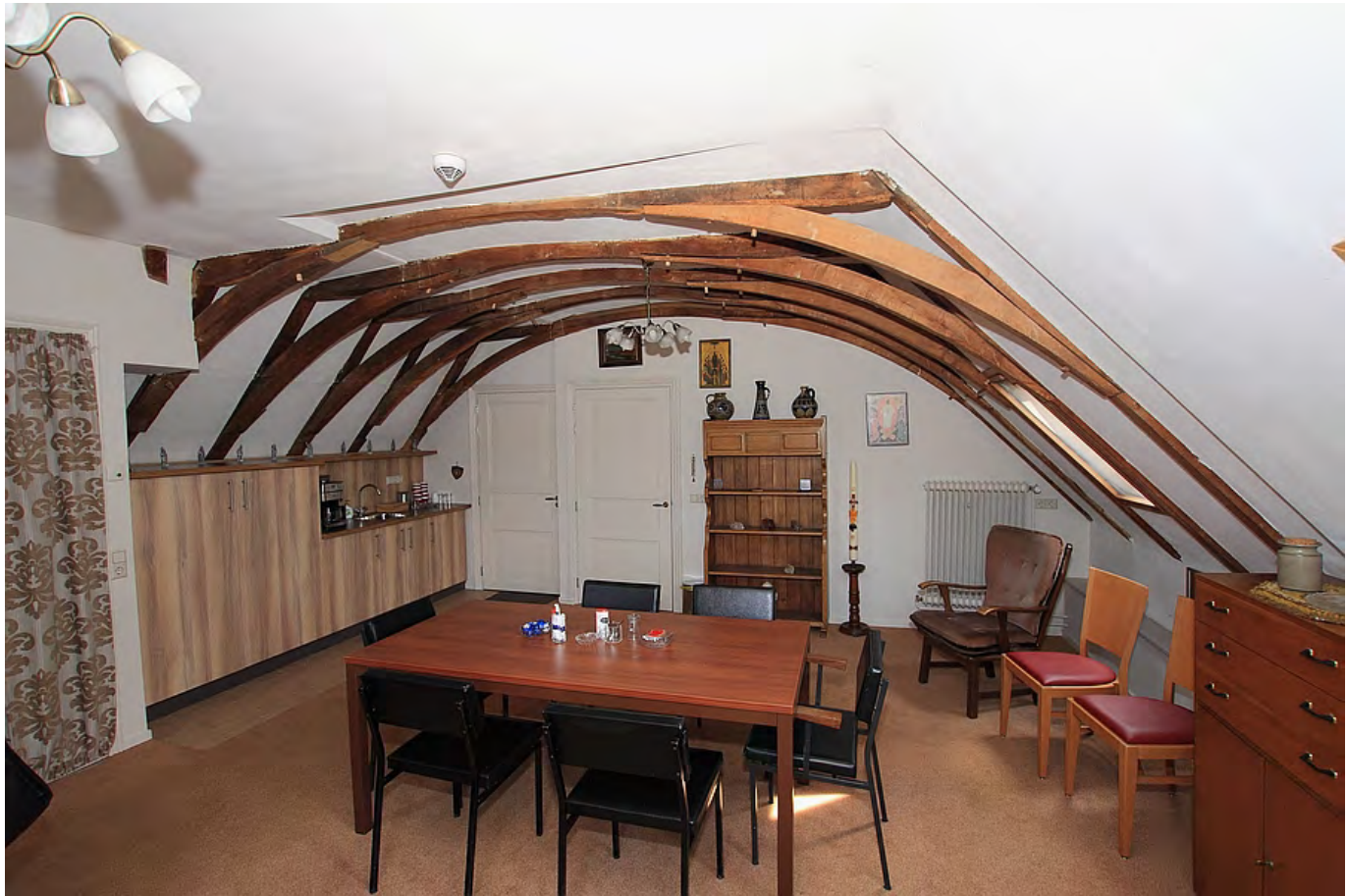
Kamer boven ridderzaal. Boogspanten zijn nog gedeeltelijk zichtbaar. Huidige (2015) situatie. De vloer van deze kamer is gelegen direct boven het tongewelf.
