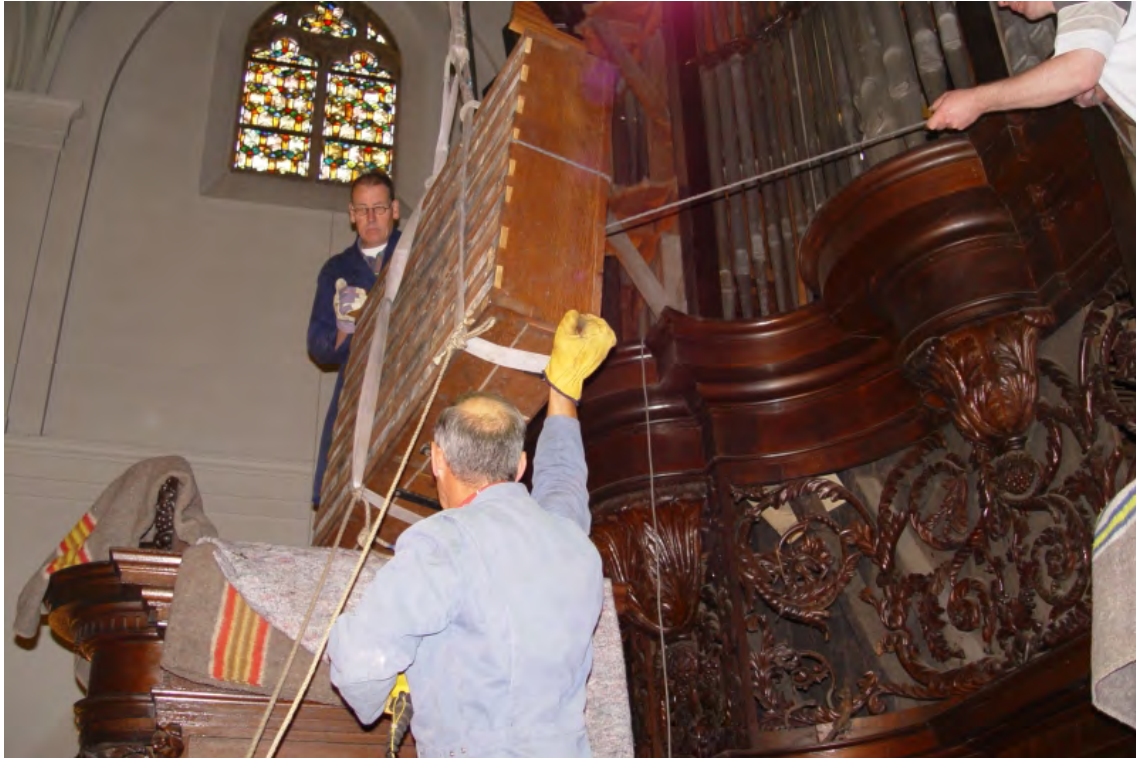
Een der windladen wordt - met als tussenstop de bovenzijde van het rugpositief - uit het orgel getakeld.
