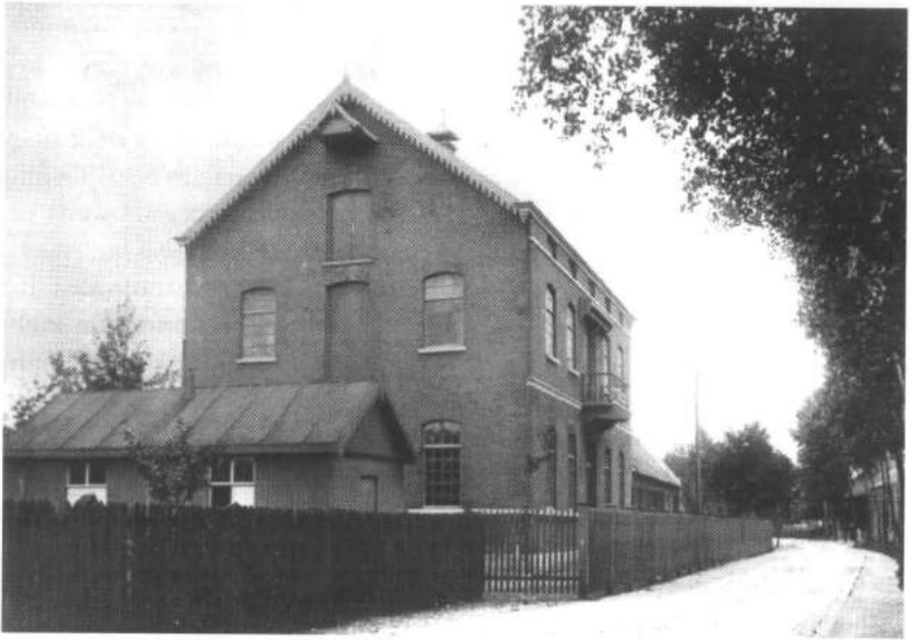
Afb. 2. Deze foto van het hoofdgebouw, opgetrokken in 1867, dateert van ongeveer 1900. In de nok van de zijgevel de katrol, waarmee de gebleekte en gewassen stukken naar de droogzolder werden gehesen.
