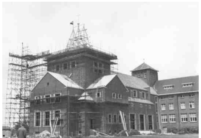
De kapel van het missiehuis in aanbouw
