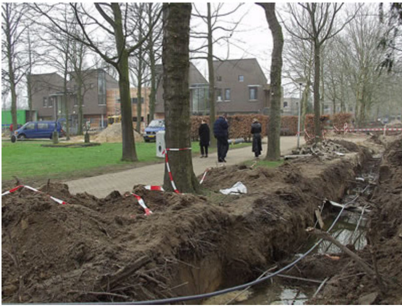
OP DE FOTO: Beeld van het eerste nieuwe woonpaviljoen op het terrein van Saltho. Op 19 maart verhuizen jongeren van de Boxtelse zorginstelling naar het pand. Momenteel wordt ook de ondergrondse infrastructuur (kabels, leidingen, riolering) op het terrein onder handen genomen.
