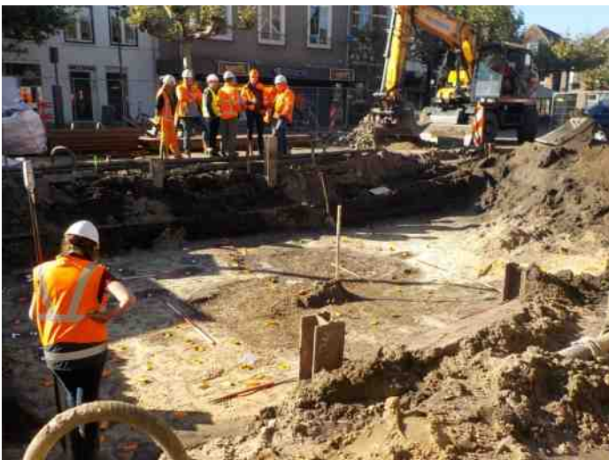
Uitgebreid overleg met zicht op de 'fonteinpompput' met sporenkaartjes
