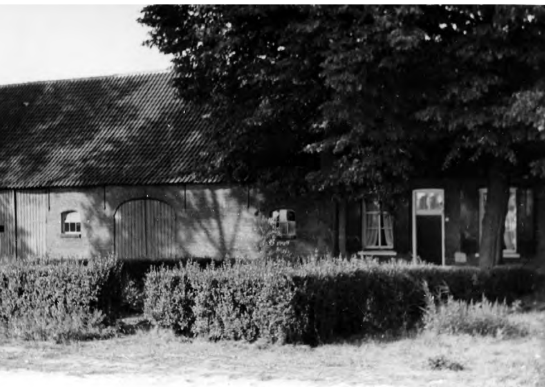
De voorgevel van de boerderij van Christianus van der Meijden gelegen op Tongeren 5.
