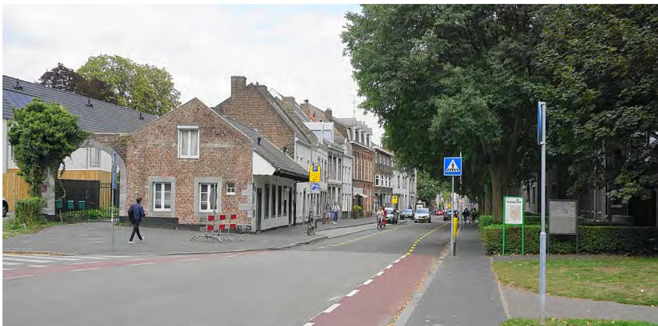
Tongerensestraat Maastricht, richting Vrijthof. Links een oud wachtgebouw uit de 18e eeuw met links ervan een poort uit Naamse steen uit 1708. Rechts achter de bomen bevond zich de in 1898 (zie eerdere foto) afgebroken 1e Marechausseekazerne van Maastricht. De Tongerensepoort bevond zich vóór, dus aan deze zijde van het hier zichtbare wachtgebouw. Foto van september 2018.
