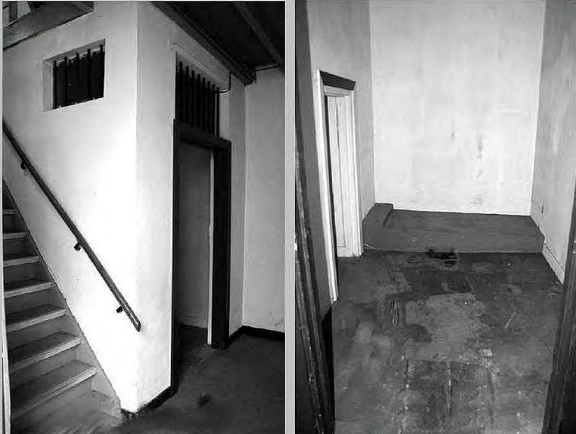
Buiten- en binnenzijde arrestantencel marechausseekazerne Grote Berg te Eindhoven, daterend van ca. 1825
