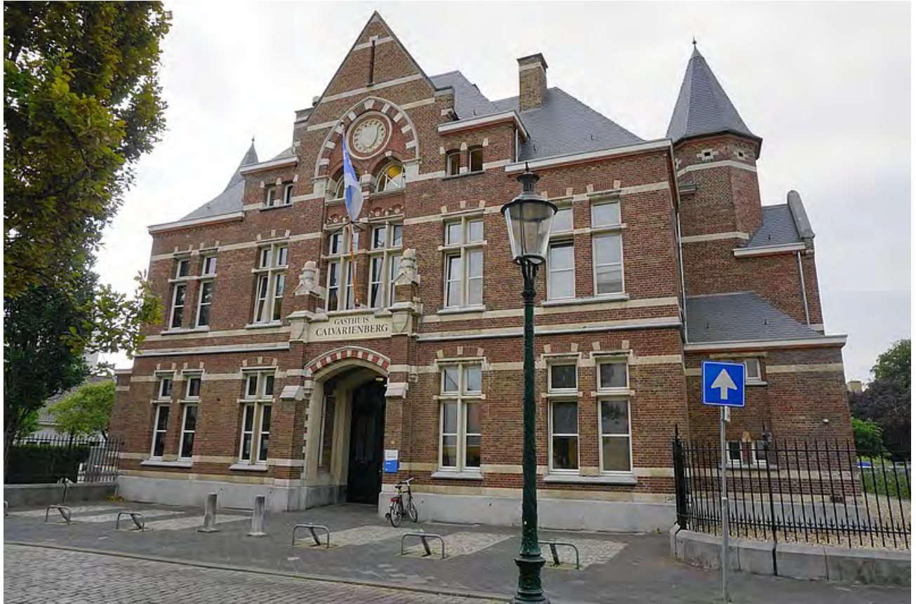
Abtmanstraat nr.2B, Elisabeth-tehuis. Gebouwd in 1887 als Gasthuis Calvariënberg naar ontwerp van de Antwerpse architecten Bildmeyer en Van Riel. Elcectische stijl. Rijksmonument. Twee huizen links van dit pand staat de voormalige woning van de directeur
