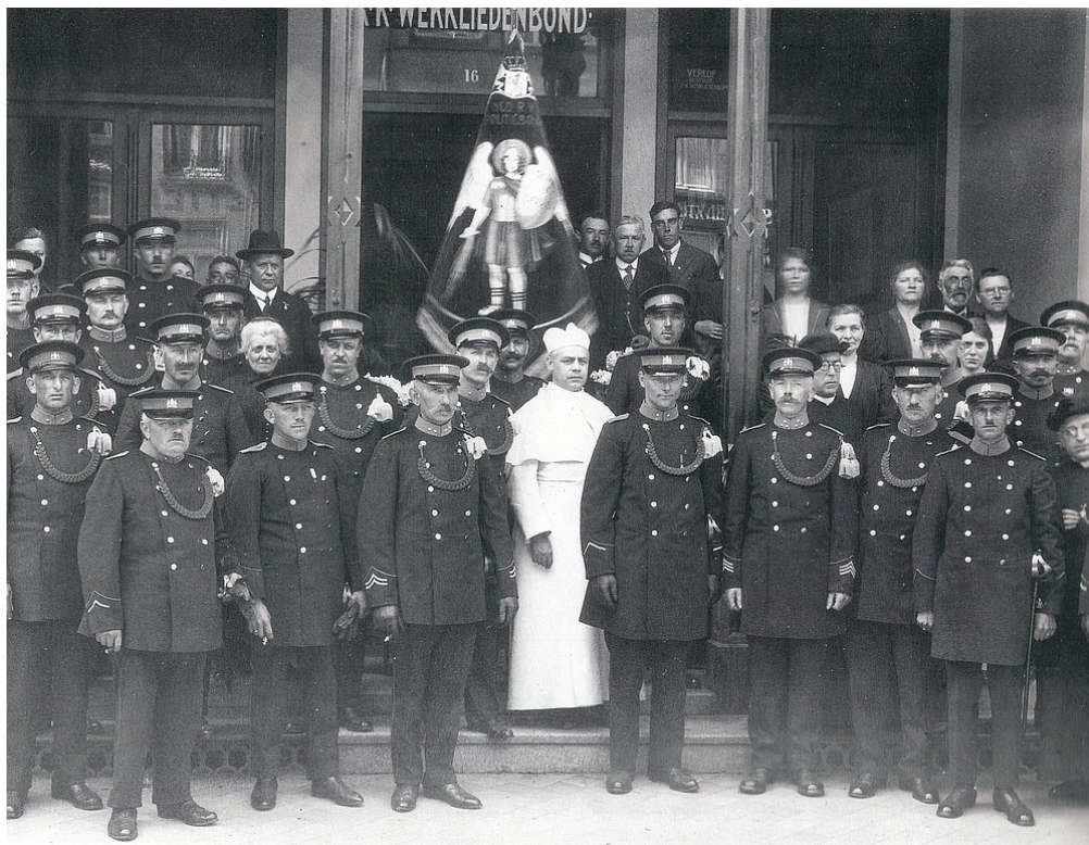
Pensmarkt te 's-Hertogenbosch, 1928. Voor het pand van de Rooms-Katholieke Werkliedenbond. Foto gemaakt bij gelegenheid van de uitreiking van een nieuw vaandel van de afdeling Rijksveldwacht van genoemde bond. De vrouw, zichtbaar links naast de linker deurstijl is Agnes Maria van Haren-van Schaijk, echtgenote van Janus van Haren, die direct links achter haar staat.
