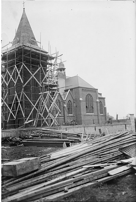
Nieuwe kerk in aanbouw
