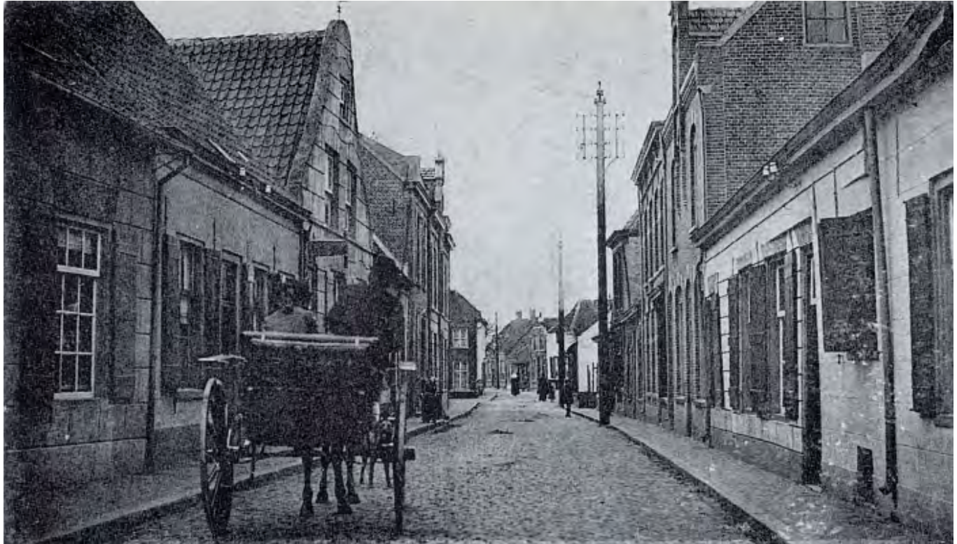
Rechterstraat te Boxtel in 1906, gezien ongeveer vanaf de hoek met de Kruisstraat richting Zwaanse Brug. Er is al elektriciteit in huizen: zie hoge masten en witte porceleinen isolatoren tegen de gevels. Links, het derde pand met hoge puntgevel is de oude herberg Sint-Cathrien 19 . Op die plek staat thans de winkel van de HEMA.
