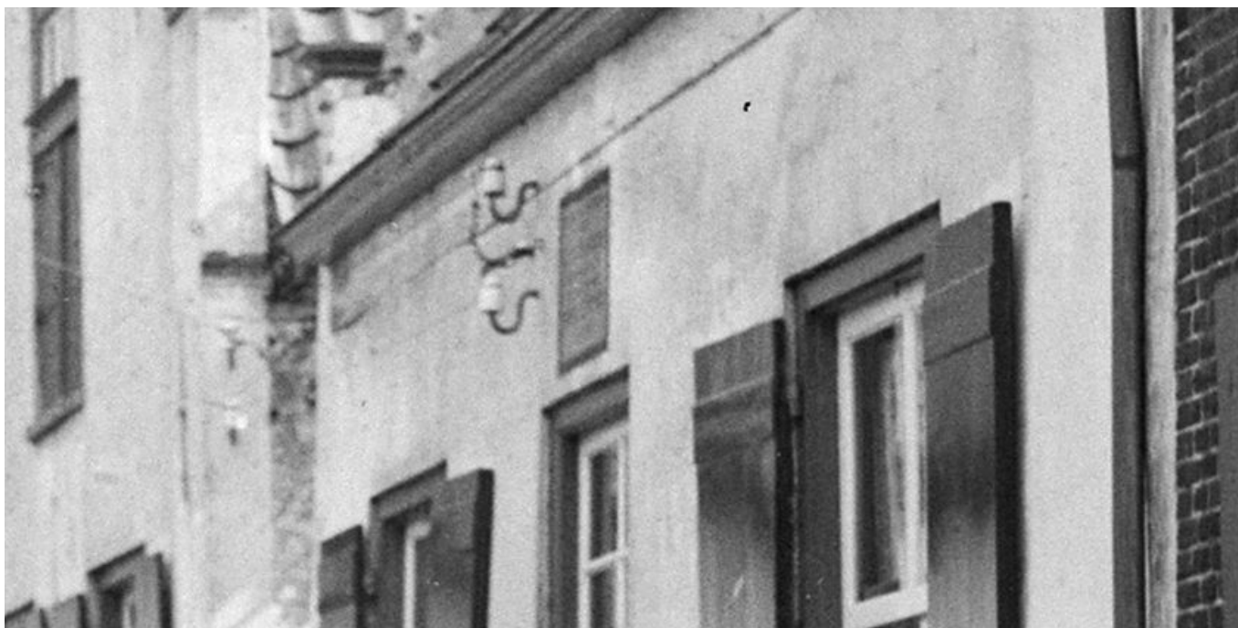
Voorgevel pand Zevengestar op de Buxtelse Mark, naast het Hofje (thans o.a. VVV-kantoor). Locatie waar thans het gemeentehuis staat. Duidelijk zichtbaar zijn de twee ijzeren beugels met porseleinen isolatoren, waar een aftakking van het bovengrondse leiding netwerk de woning binnengaat. Op oudere foto's van dit pand zijn deze beugels en isolatoren nog afwezig.
