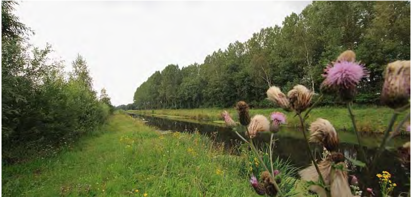
Afwateringskanaal omgeving Leemputtenbrug. In gebruik sinds halverwege 1935
