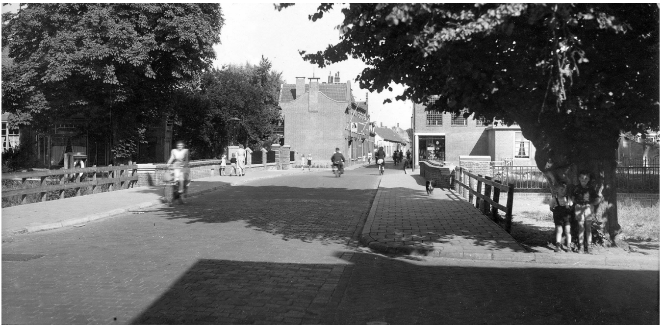
Foto van betrekkelijk kort na de heropening van de nieuwe brug, mogelijk omstreeks 1950. Vooral op de rechter leuning is duidelijk de ijzeren, gehoekte band te zien die in het midden in de lengterichting is aangebracht.
