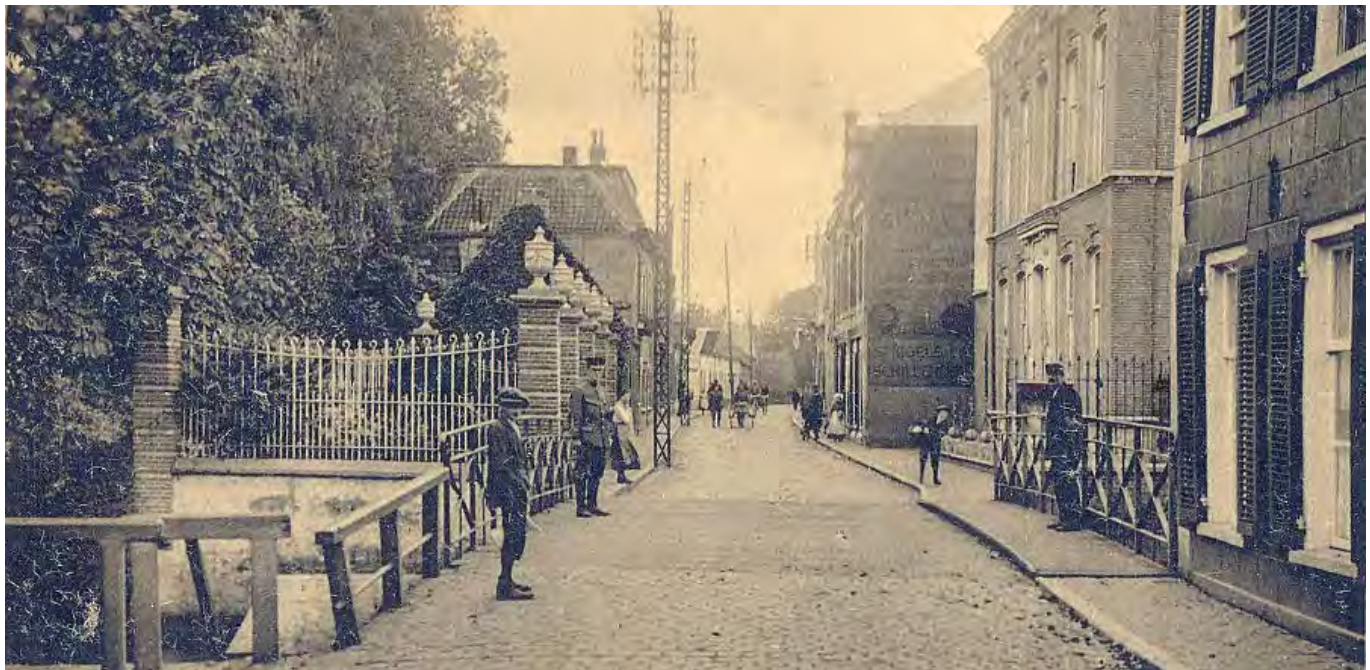
Zwaanse Brug omstreeks 1914-1918. Ijzeren brugleuningen en houten wegdek, slechts aan één zijde ligt een trottoir, links met houten leuningen, de trap naar de Dommel
