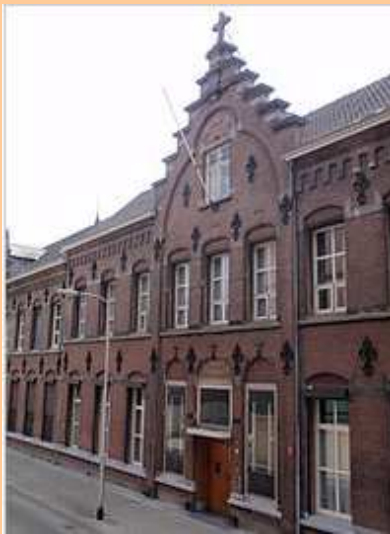
Leo werkte aan het moederhuis van de zusters van Liefde van Tilburg aan de Oude Dijk 1 (1890-1916)
