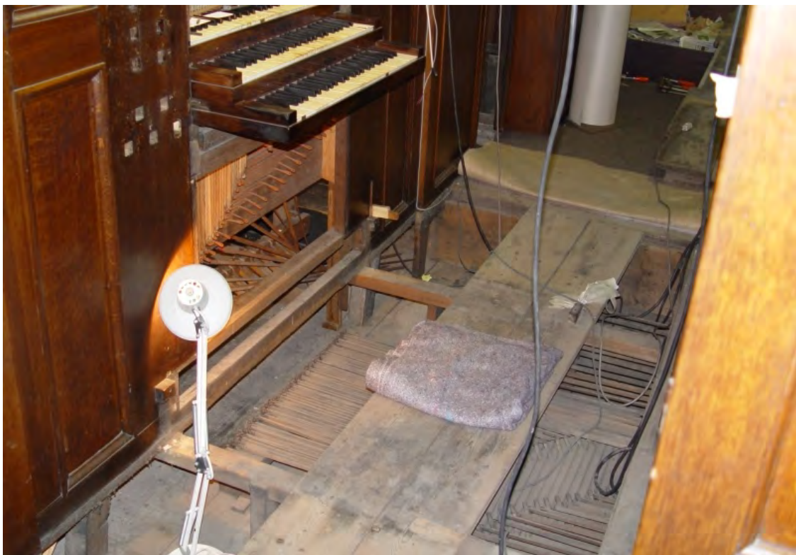
Tractuur loopt onder vloer speeltafel - vloer hier gedeeltelijk verwijderd - naar rugpositief. Merk op hoe stoffig en vuil het onder de vloer (nog) is.
