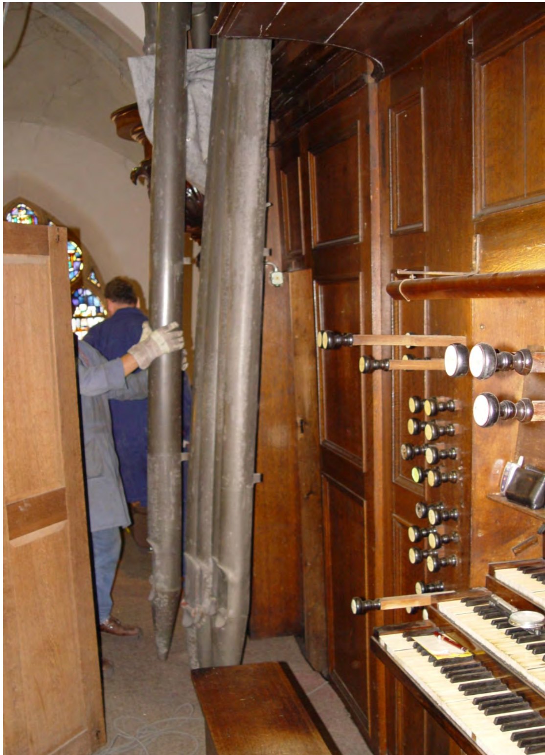
Gedemonteerde pijpen, uit de linker pedaaltoren, krijgen even een plaats naast de speeltafel van het orgel. Donderdag 26 augustus 2004. Daarna gaan ze, over de balustrade aan de zuidkant, naar beneden, en vervolgens naar de torenhal tot het moment van overbrengen naar Heythuysen. Dit zijn de langste en laagst klinkende pijpen uit het Boxtelse Smits-orgel.
