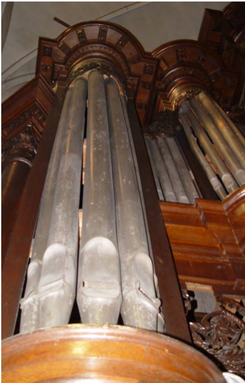
Pijpen in een van de twee pedaaltorens van het Boxtelse Smits-orgel. Deze pijpen zijn nog origineel Smits' werk uit 1842.
