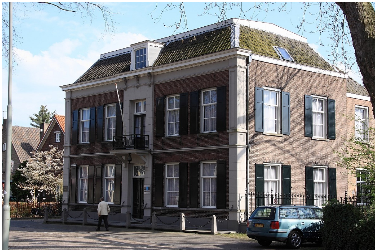
Clarissenstraat 22 Boxtel. Thans notariskantoor. Op deze plek wordt in 1787 een herenhuis gebouwd door Johan van den Ham, oud-pachter van het schuin er tegenoverliggende Barrièrehuis no. 3. Omstreeks 1880 ver- dan wel herbouwd. Er omheen lag een grote tuin. (Foto: Ruud van Nooijen)
