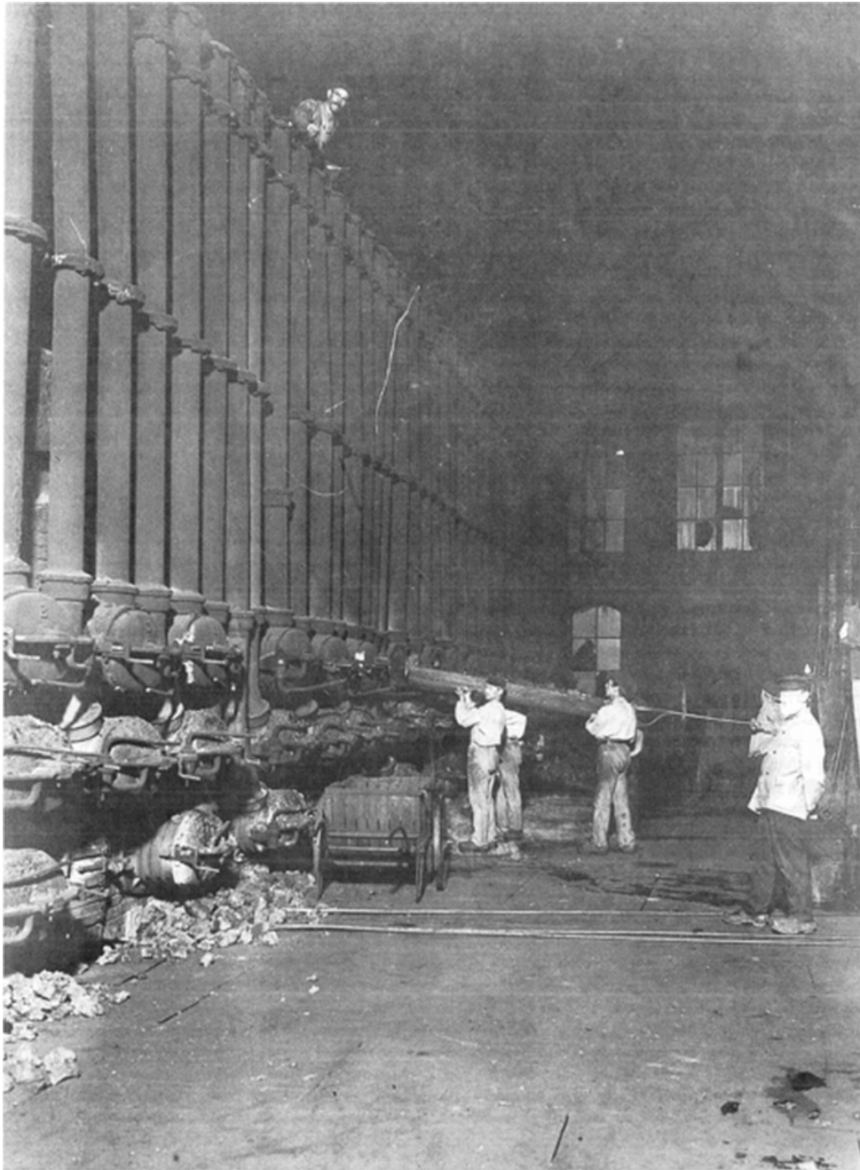
Steenkolengasfabriek Rotterdam, ca. 1890. Retorten gasoven.
