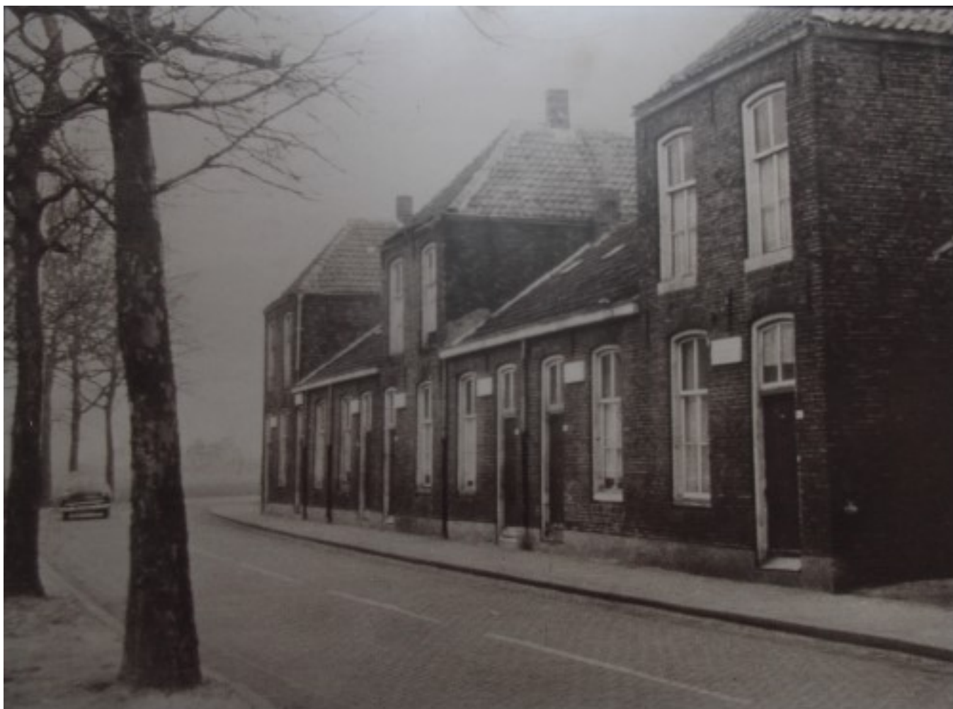
Eerste Boxtelse gasfabriek aan de Nieuwstraat, gebouwd in 1865. Na sluiting werd het pand omgebouwd tot een aantal woningen. Gesloopt bij realisering wijk Boxtel-oost. Foto van ca. 1955, derhalve ruimschoots na ombouw tot woningen.
