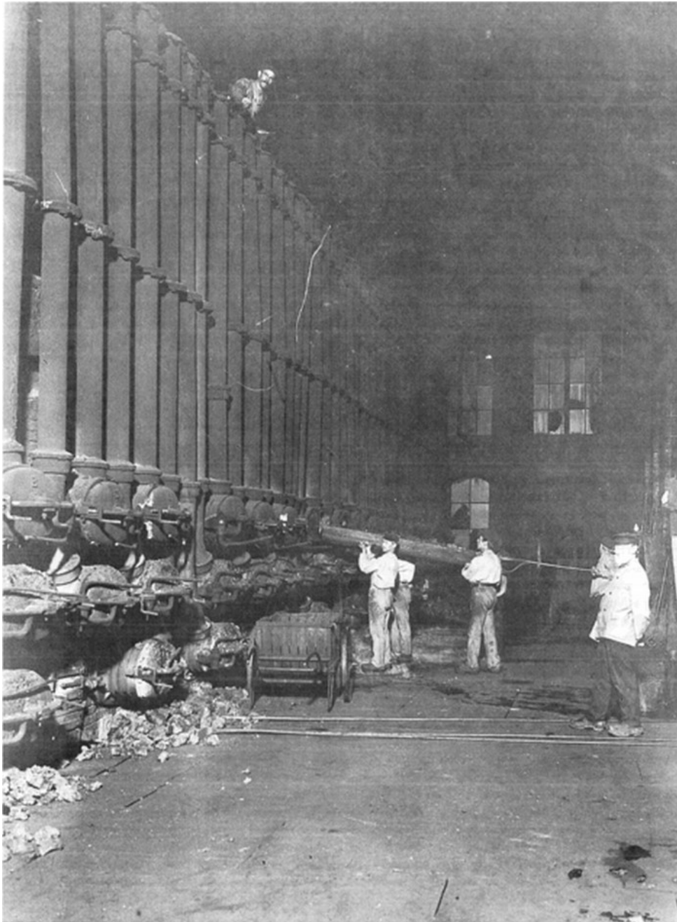
Steenkolengasfabriek Rotterdam, ca. 1890. Retorten gasoven.
