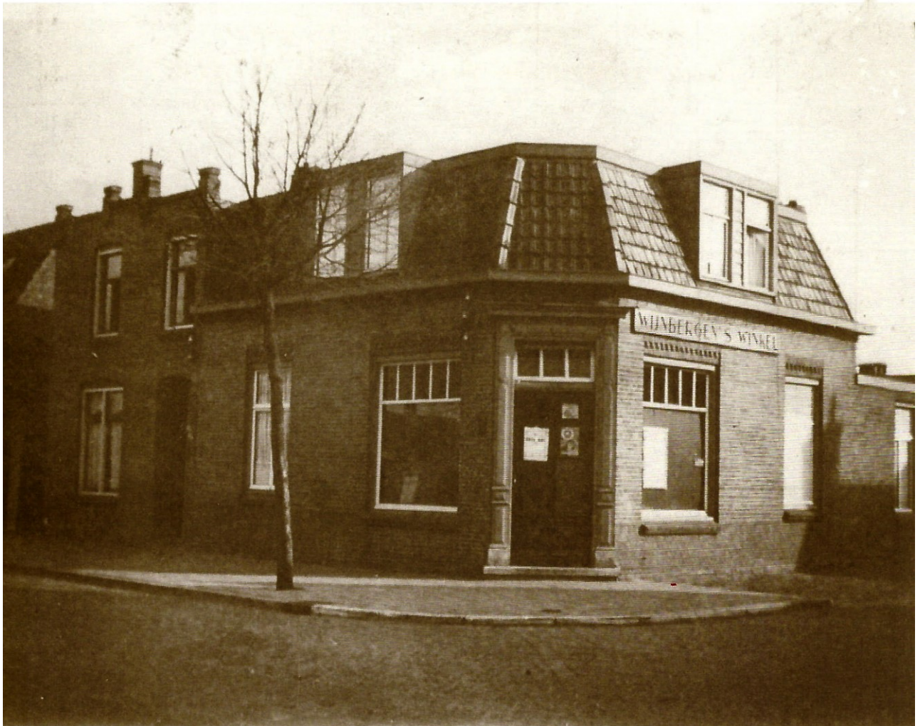
Slagerij van Geert Strijbosch op hoek Kasteellaan en Frans Staelstraat te Boxtel op de rechtergevel een bord met opschrift WIJNBEGEN'S WINKEL 18
