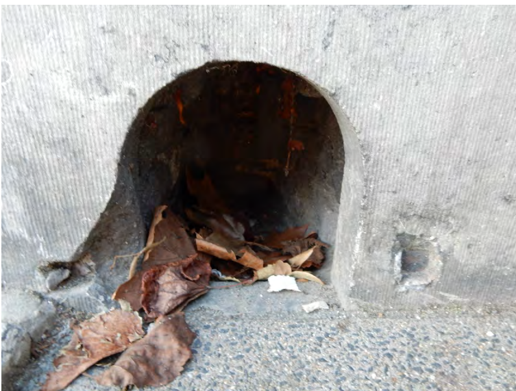
Willemstraat 27. Het smeedwerk is er zichtbaar vanaf gesloopt.
