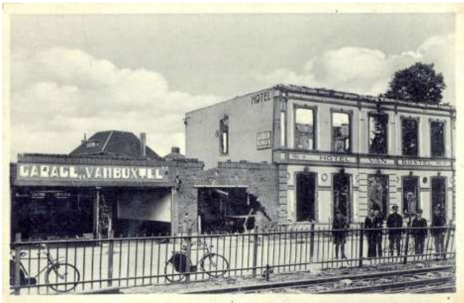
Uitgebrande panden in de stationsbuurt, ten gevolge van de Engelse luchtaanval op 22-23 mei 1940. Gepubliceerd op www.beeldbankboxtel.nl , collectie Wim Baaijens, inv.-nr. hkbo3079.
