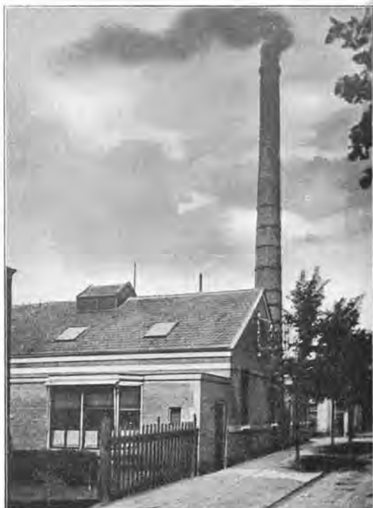
Kantoorzijde der Electricische Centrale.
