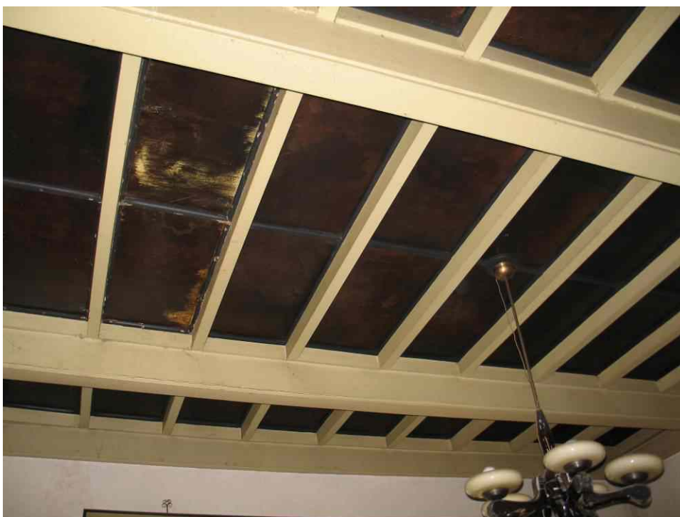
Afb. 18 en afb. 19 Overzichten woonkamer, plafonds
