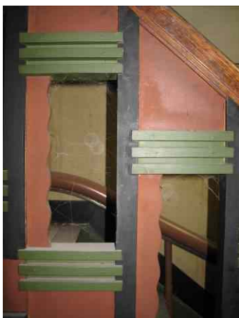
Afb. 30, afb. 31, afb. 32, afb. 33 en afb. 34 Details vestibule en trappenhuis
