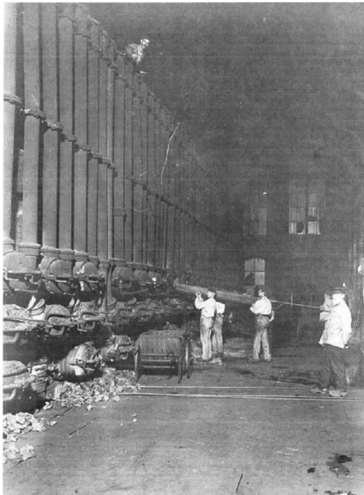
Steenkolengasfabriek Rotterdam, ca. 1890. Retorten gasoven.
