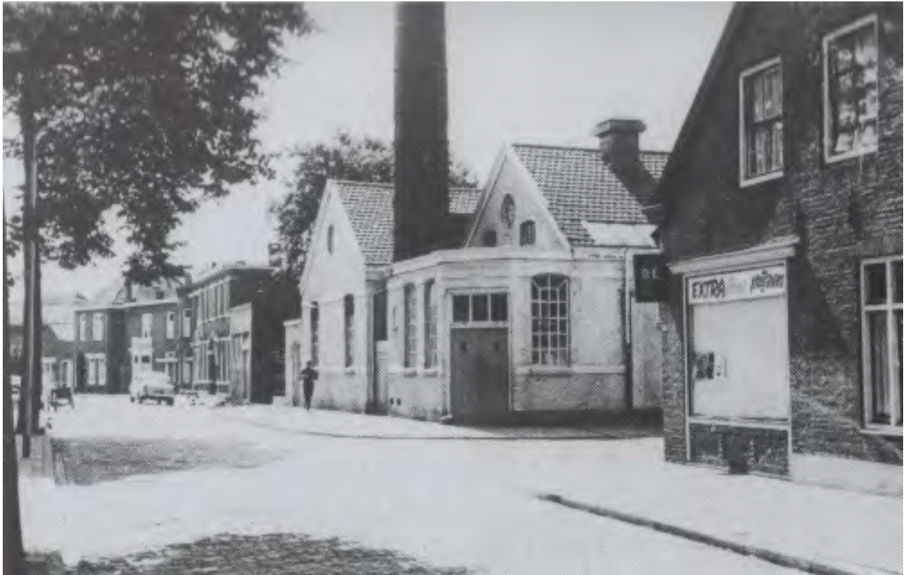
Boxtelse Elektriciteitscentrale aan de Van Leeuwenstraat met rechts de Van Oschstraat, de eerste elektriciteitscentrale in geheel Noord-Brabant. In gebruik tussen 1899 en 1946.
