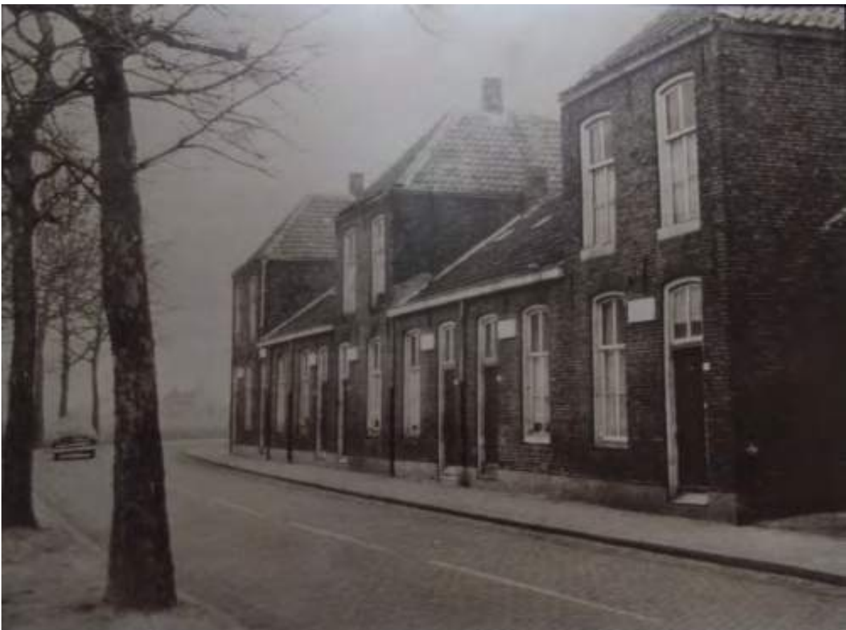
Eerste Boxtelse gasfabriek aan de Nieuwstraat, gebouwd in 1865. Na sluiting werd het pand omgebouwd tot een aantal woningen. Gesloopt bij realisering wijk Boxtel-oost.
